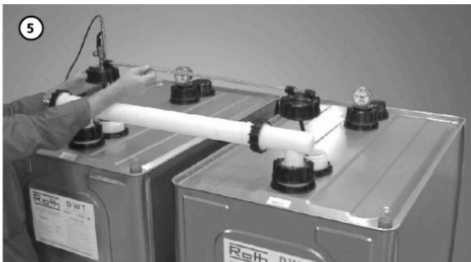
Трубу для отбора установите на второй штуцер резервуара; при этом смонтируйте арматуру для сбора вместе с датчиком GWG на первом резервуаре в направлении заливки; настройте датчик предельных значений в соответствии с таблицей.
