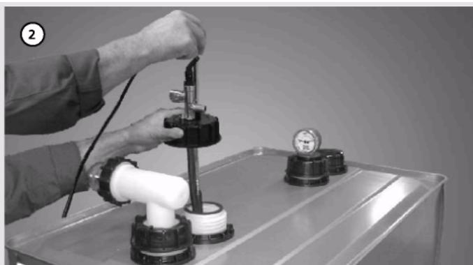
Установите сборную арматуру для отбора вместе с датчиком предельных значений на второй штуцер резервуара.
