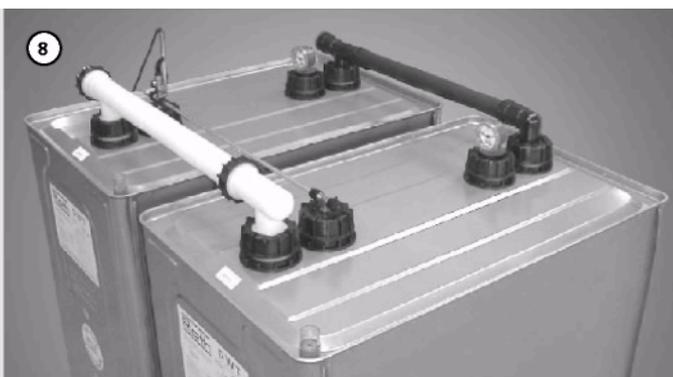
Полностью смонтированная система трубопроводов.
