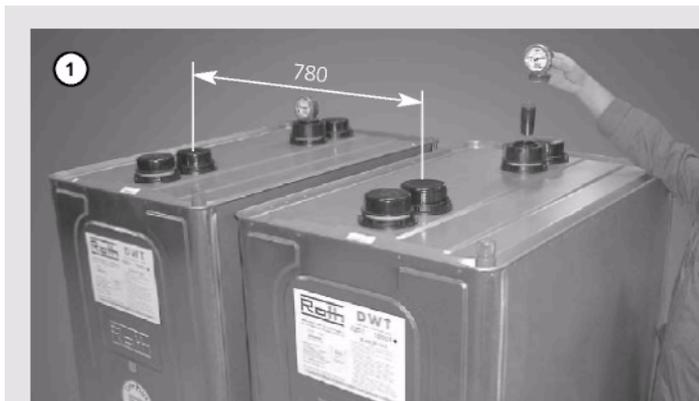
Установите резервуары на ножки и таким образом, чтобы расстояние между центрами соседних резервуаров составляло 780 мм; ввинтите часы с указателем уровня заполнения в резьбовые втулки на третьем штуцере резервуара.
