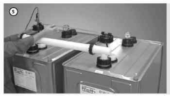
Трубу для отбора установите на второй штуцер резервуара; при этом смонтируйте арматуру для сбора вместе с датчиком GWG на первом резервуаре в направлении заливки; настройте датчик предельных значений в соответствии с таблицей.
