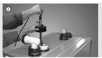
Установите сборную арматуру для отбора вместе с датчиком предельных значений на второй штуцер резервуара.
