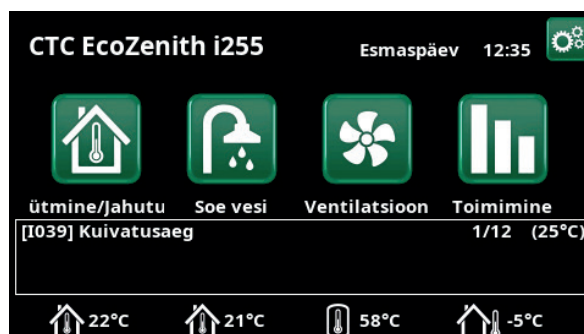
Näide Põrandakuivatuse temp päeval 1/12, kui seadistus on 25 °C.
